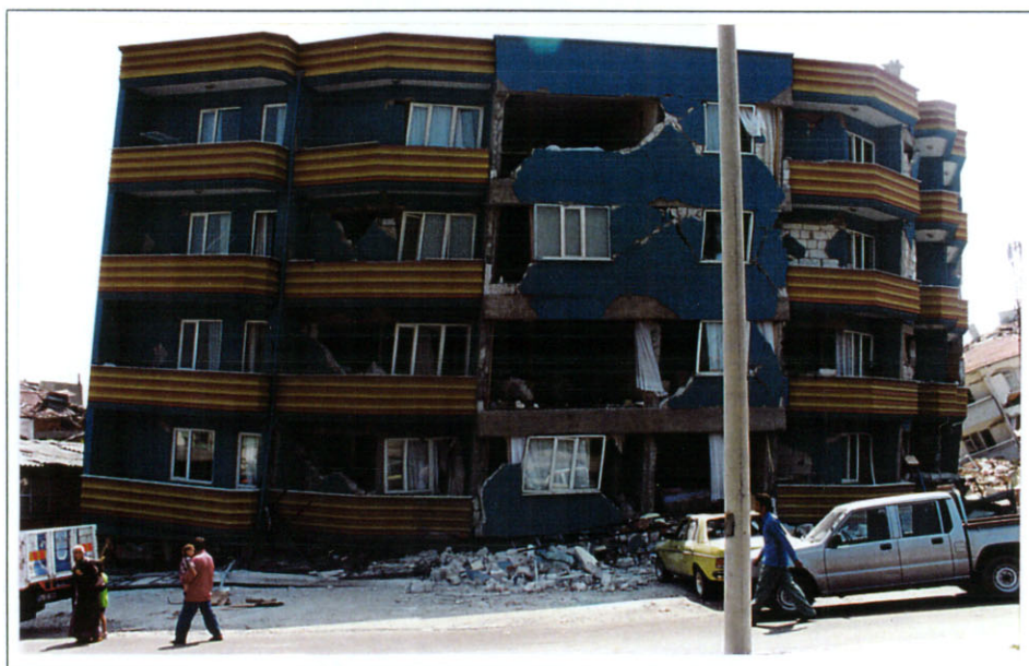
Εικ. 13 Κτίριο στο Adarazarı με εύκαμπτο ισόγειο όροφο που κατέρρευσε.
