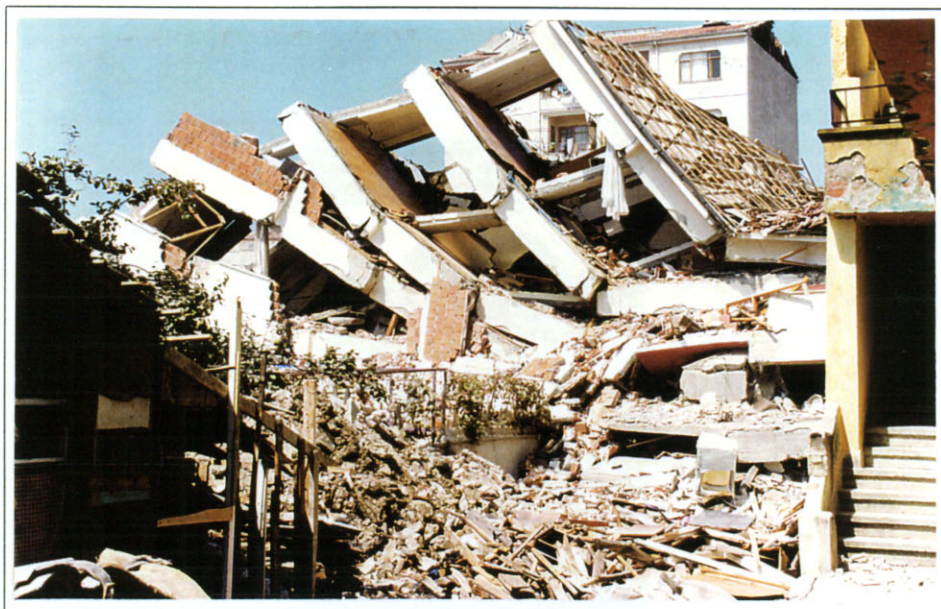
Εικ. 12 Υπό κατασκευή κτίριο που κατέρρευσε. Είναι εμφανής ο μηχανισμός κατάρρευσης.
