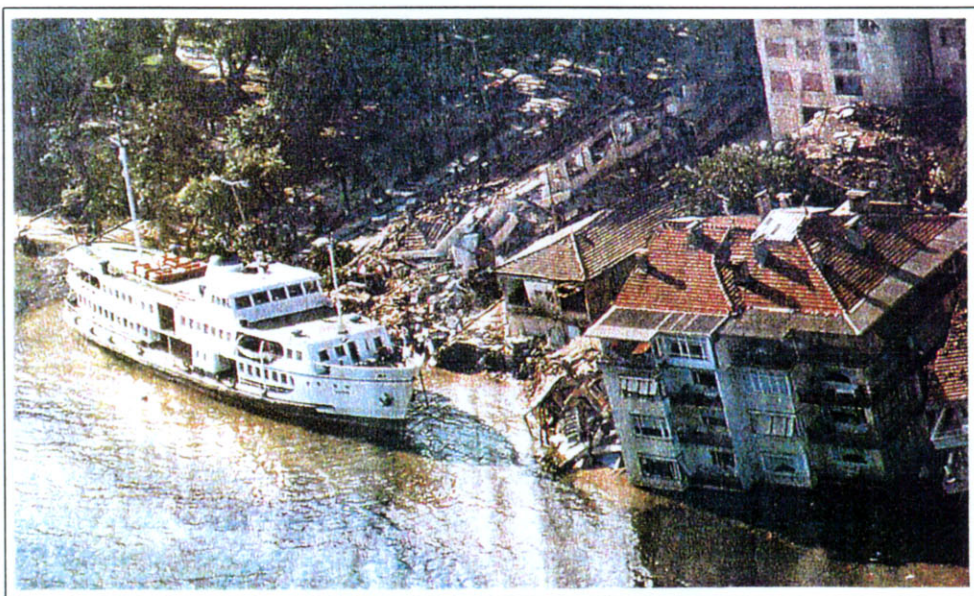
Εικ. 9 Καταστροφές από κύματα tsunamis και καθοδικές κινήσεις στην παράκτια περιοχή δυτικά του Gölçük. Διακρίνεται το πλοίο που ξεβράστηκε.
