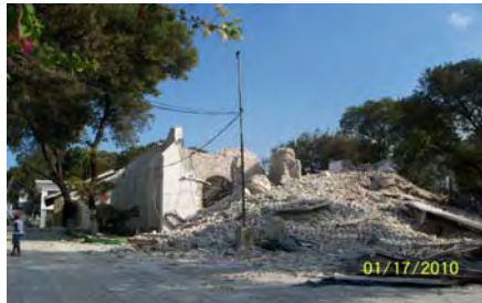
Εικ. 16 Οι τοξωτές κατασκευές επέζησαν.
