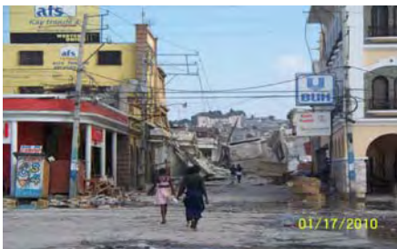
Εικ. 18 Τυπική άποψη από δευτερεύοντα δρόμο.
