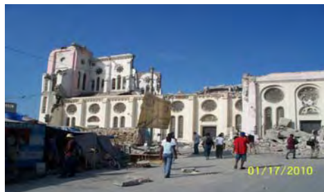
Εικ. 24 Ο τρούλος του μητροπολιτικού ναού κατέρρευσε μέσα στην κάτοψη του.
