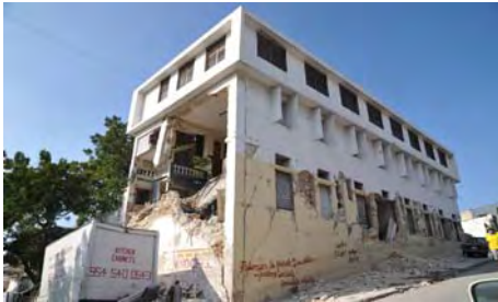
Εικ. 22 Κατάρρευση μέσα στην κάτοψη του.
