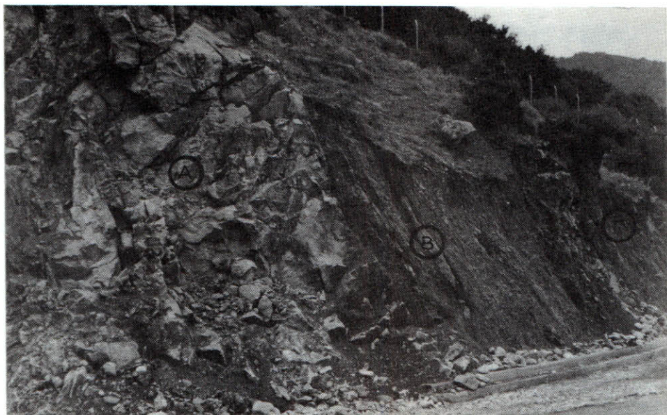
Εκ. 11. Άποψη των μεταβατικών στρωμάτων (B) μεταξύ των ωλιθικών-μικρολατυποπαγών ασβεστόλιθων (A) και των ραδιολαριτών-πηλιτών (Γ) απέναντι από το βόρειο άκρο της κρεμαστής γέφυρας του Πορταϊκού στην Πύλη.
