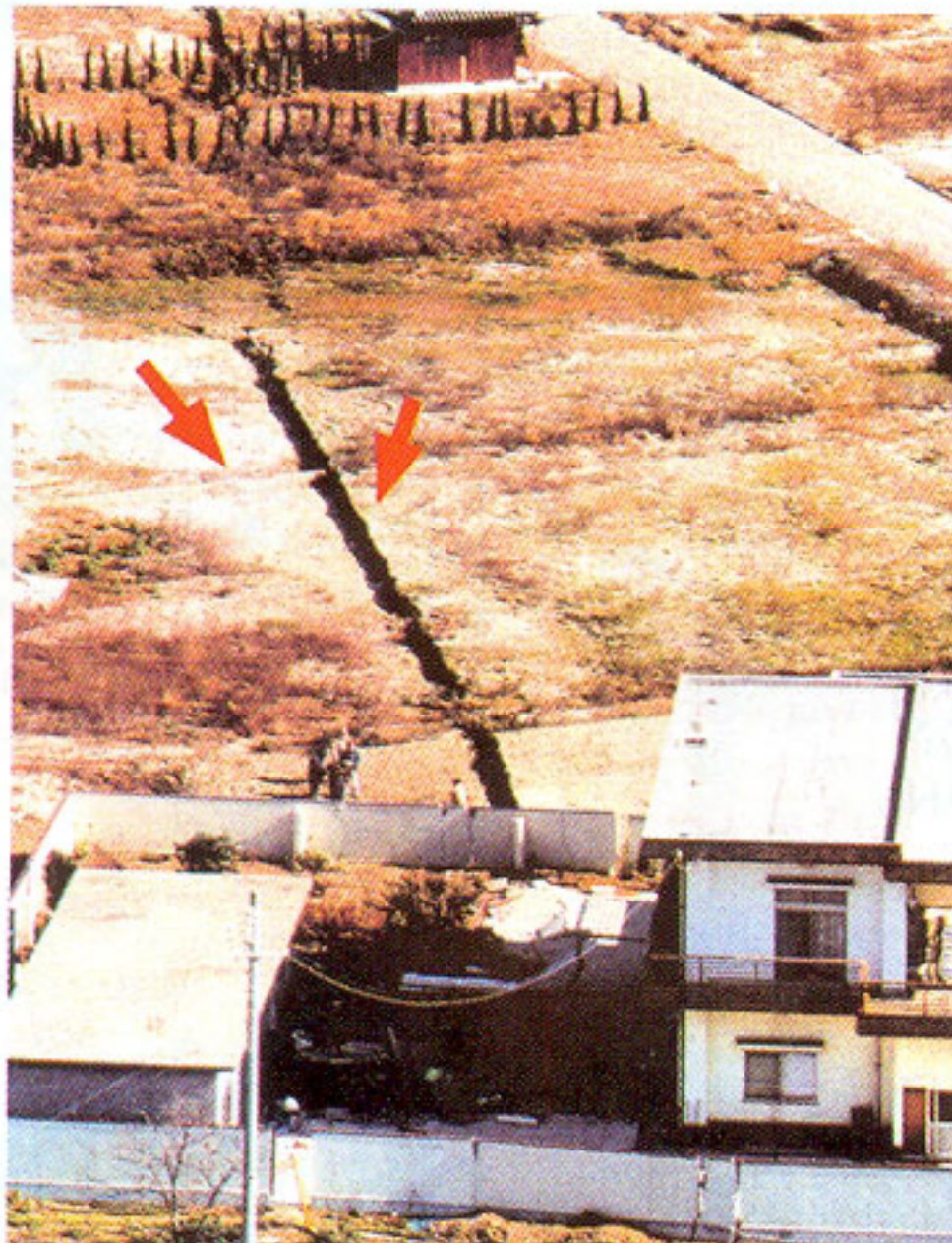
Εικ. 3 Ταυτόχρονη εμφάνιση ανάστροφου σεισμικού ρήγματος και ρευστοποιήσεων κατά το σεισμό του Kobe (βέλη).
