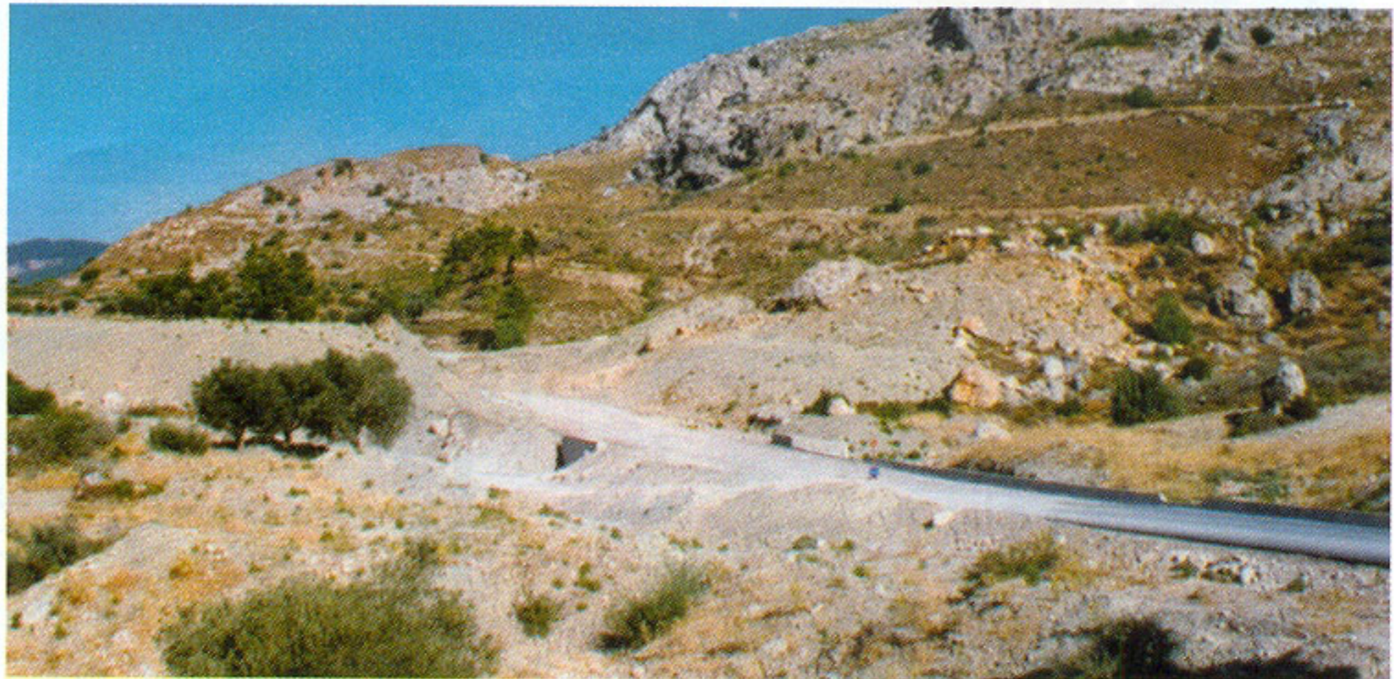
Εικ. 2 Εκδήλωση κατολισθήσεων κατά μήκος ρηξιγενούς ζώνης στην οδό Πλατανιά - Απόλλωνα Ρόδου.
