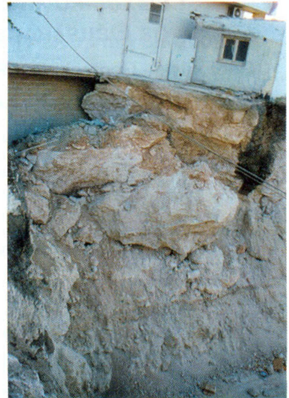
Εικ. 1 Υποχώρηση βραχωδών τεμαχών που προήλθαν από τη δράση ρηξιγενούς ζώνης στην πόλη της Ρόδου.
