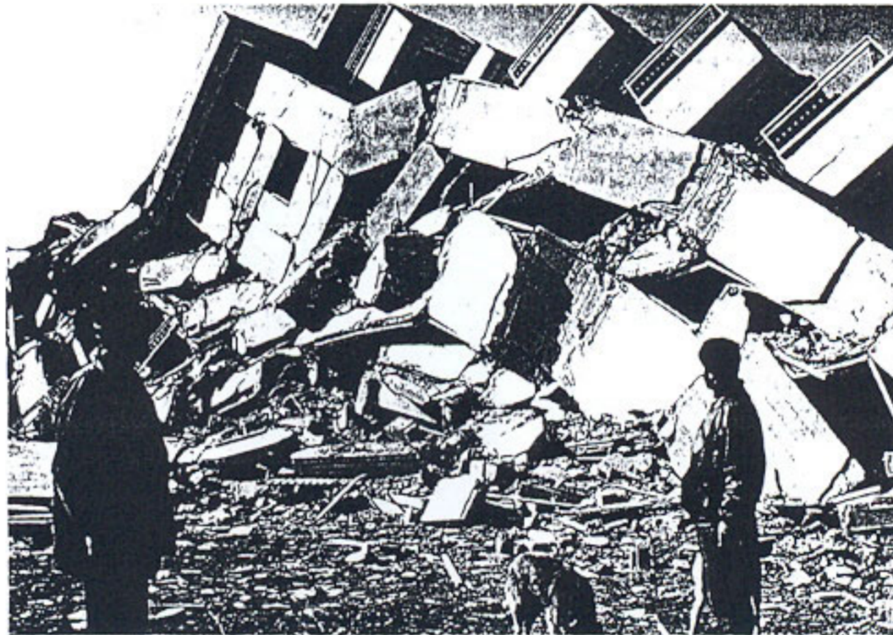
■ Τα ερείπια. Οι κάτοικοι της πόλης Σουλτάν-νταγ παρατηρούν ότι απόμεινε από εξαώροφη πολυκατοικία που κατέρρευσε μετά τον χθεσινό σεισμό
