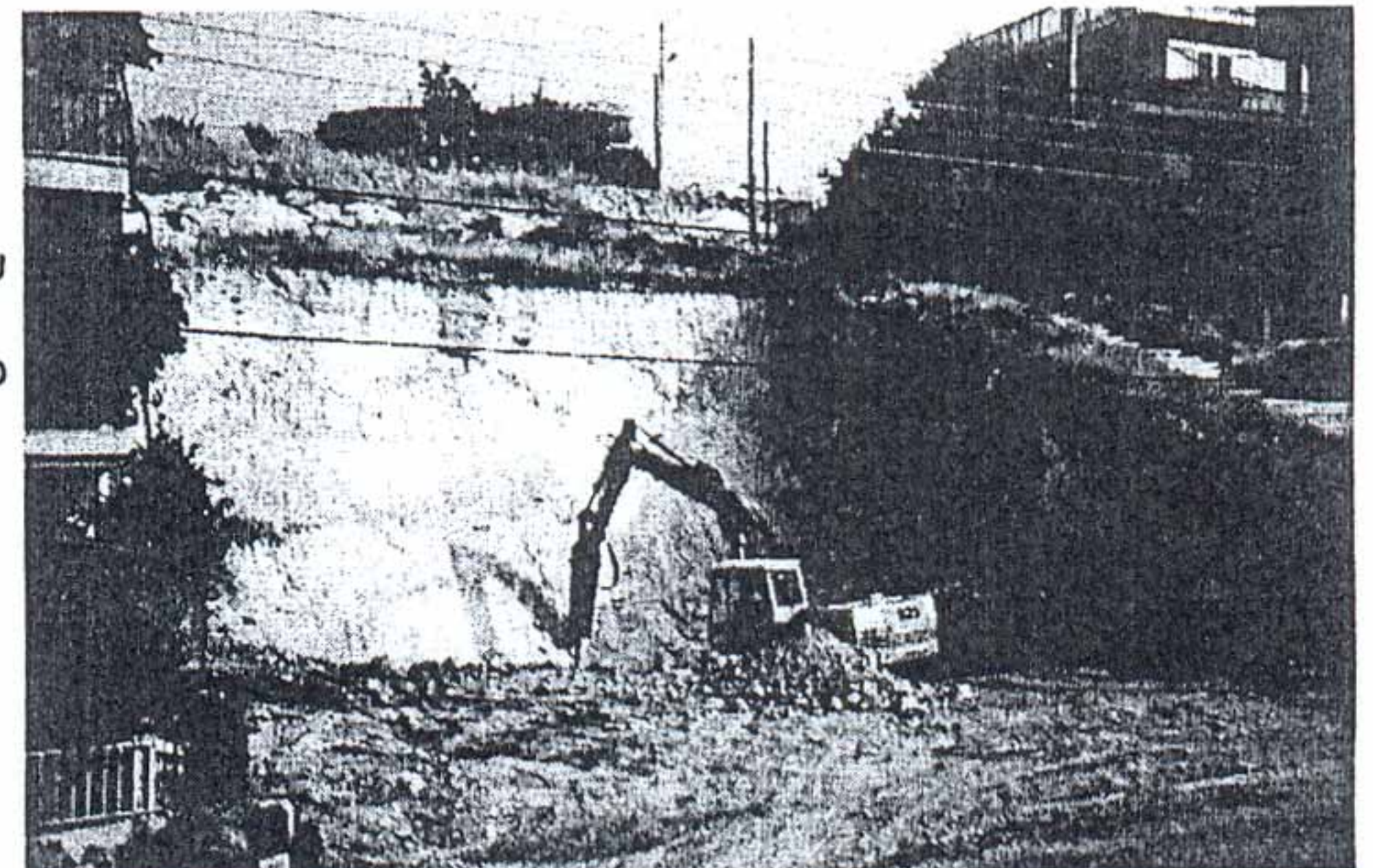
Ένα από τα δεκάδες κρυφά ρήγματα μέσα στον οικιστικό χώρο της πρωτεύουσας που αποκαλύφθηκαν σε πρόσφατες εργασίες θεμελίωσης οικοδομής
