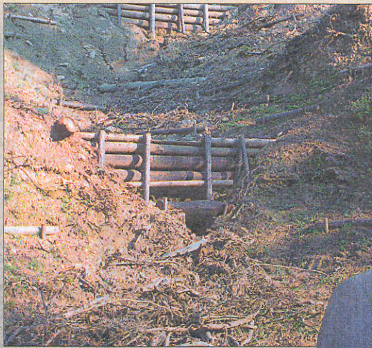
Η διάβρωση του εδάφους στον Ταΰγετο, στη θέση Λαδά, είναι εμφανής λόγω κακοτεχνιών στα αντιδιαβρωτικά έργα
