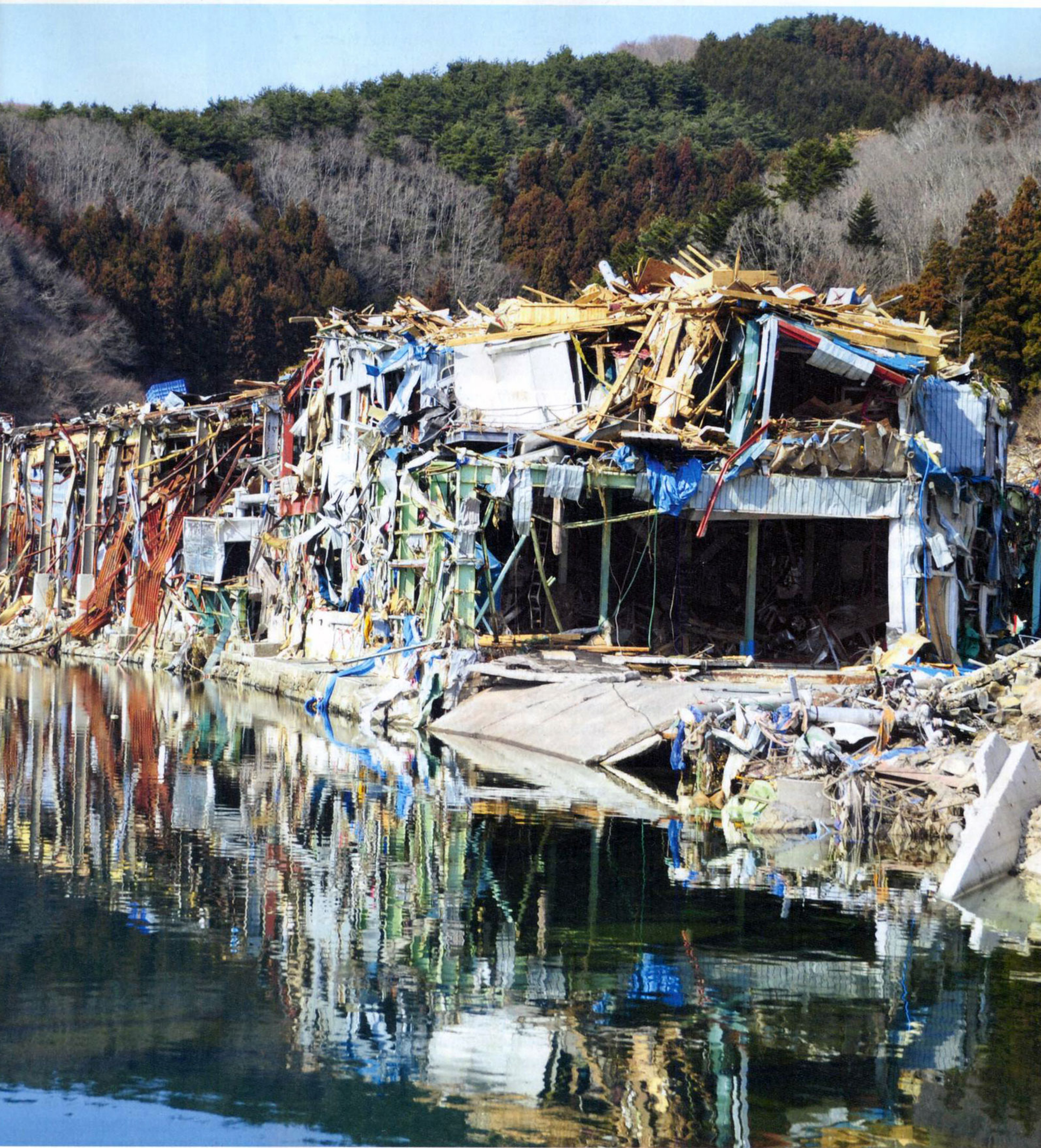
Μόνο οι σκελετοί των κτιρίων έμειναν στη θέση τους από την ορμή του τσουνάμι σε αυτή την περιοχή της Οναγκάουα.
